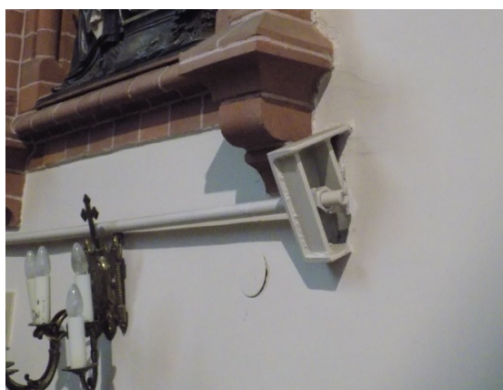
Rys. 2 Zakotwienie ściany transeptu
