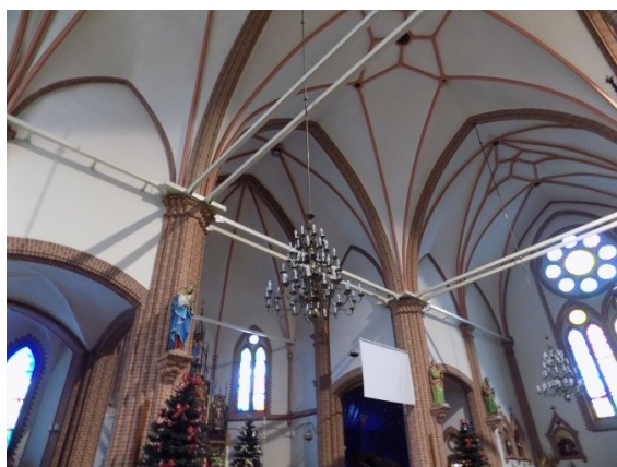
Rys. 1 Stężenia głowic filarów
