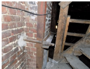
Rys. 9 Kotwy ściany szczytowej
