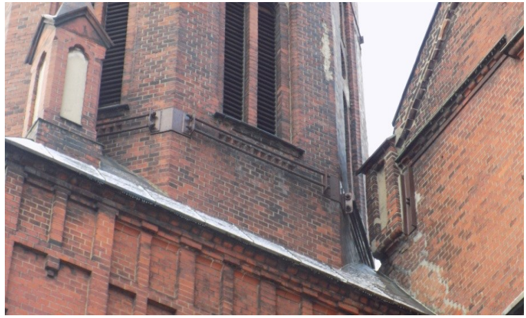
Rys. 3 Stalowy „kołnierz” południowej wieży
