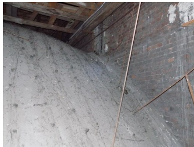
Rys. 8 Sklepienie Rabbitz, pokryte elastyczną żywicą. Na pierwszym planie widoczne pozostałe stężenie
